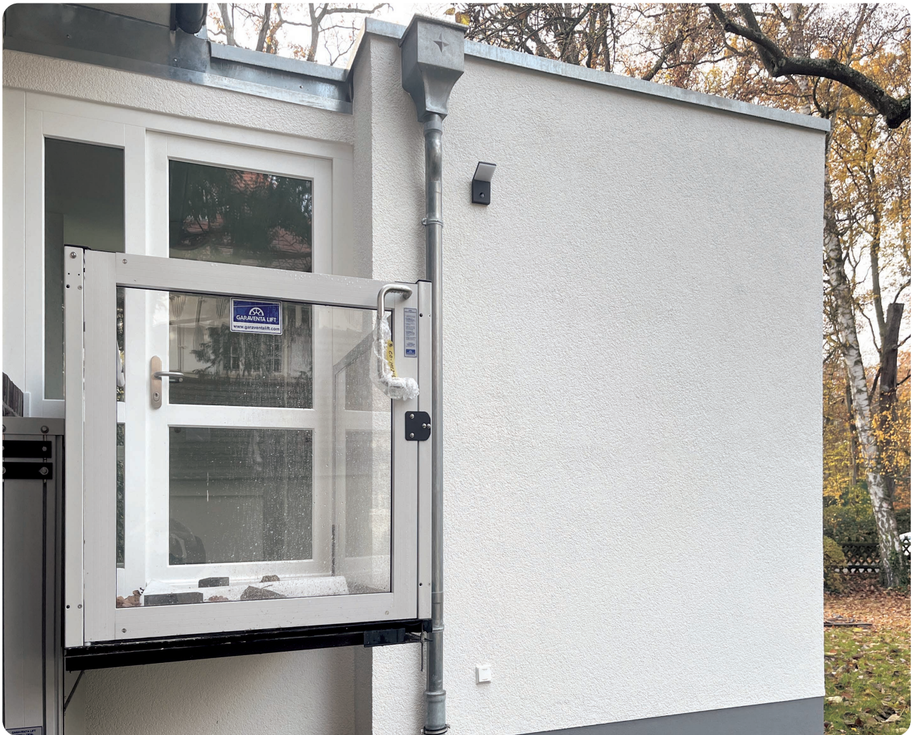
Eine Erleichterung für behinderte Menschen, die neue Aufzugsanlage
